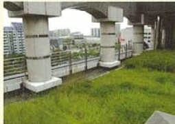
▲ 緑化された屋上
